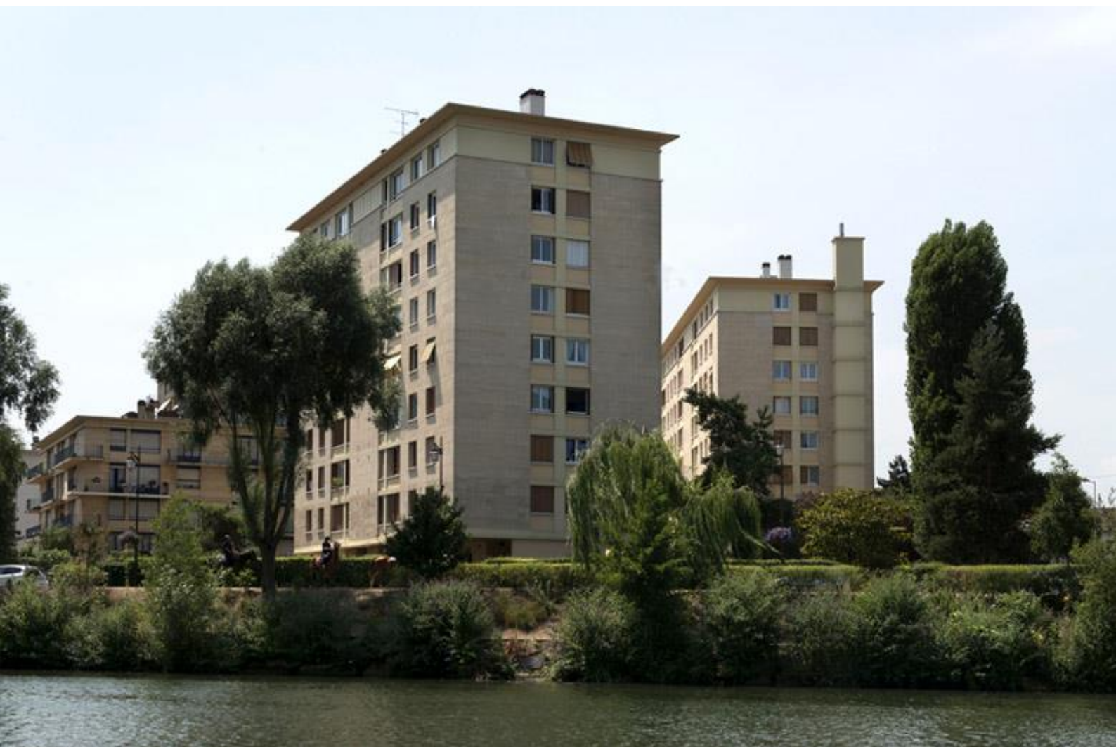
Résidences Quai de la Tour et Saint-Maclou Mantes-la-Jolie
